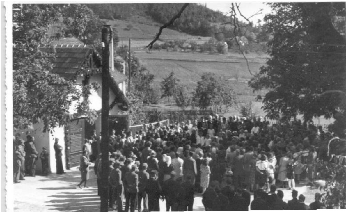
Unser erstes Feuerwehrhaus
