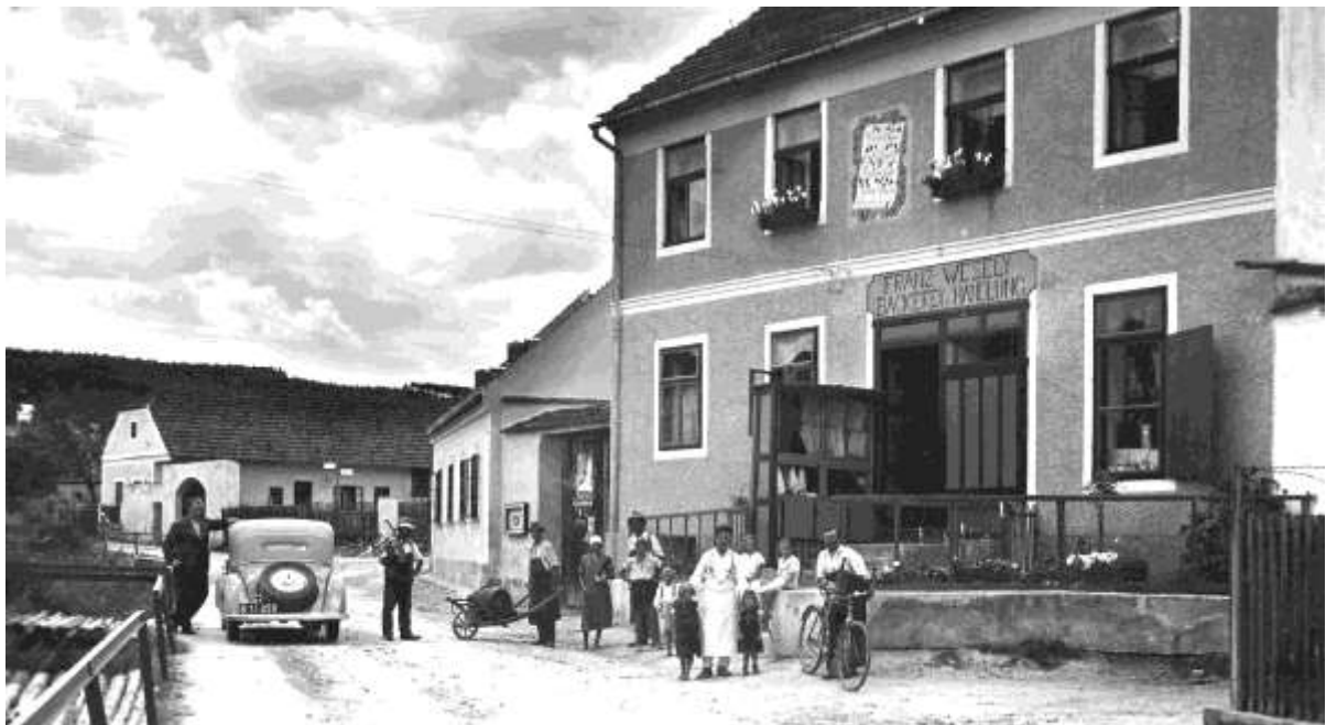
Eines der beiden Kaufhäuser in Höbenbach – Franz Wesely. Bäckerei & Handlung.
