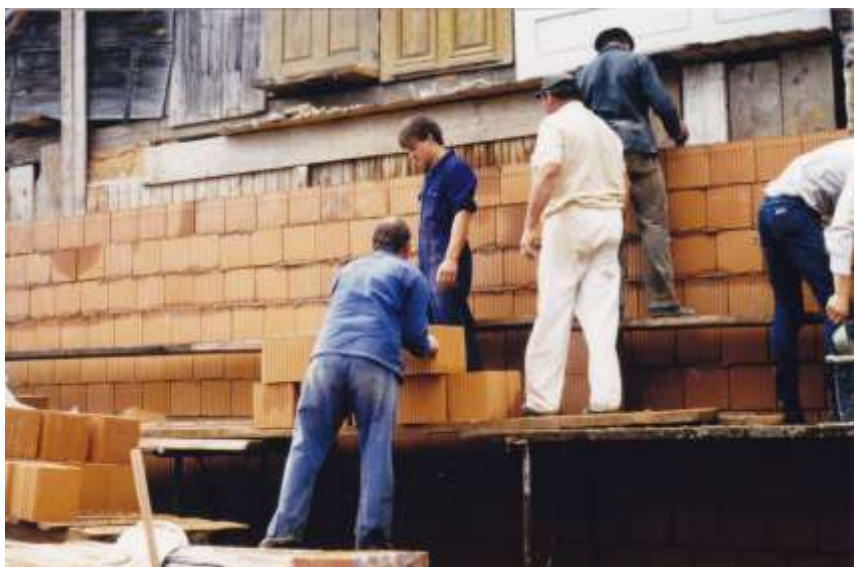
Die Fahrzeughalle entsteht.
